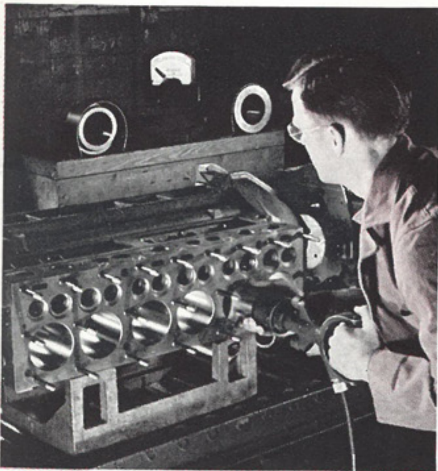
Pour procéder à des mesures de haute précision, on a, grâce à certains perfectionnements, fait appel aux données rigoureusement exactes, que fournit l'électricité. Cette gravure montre comment on s'en sert pour vérifier le diamètre des cylindres.
